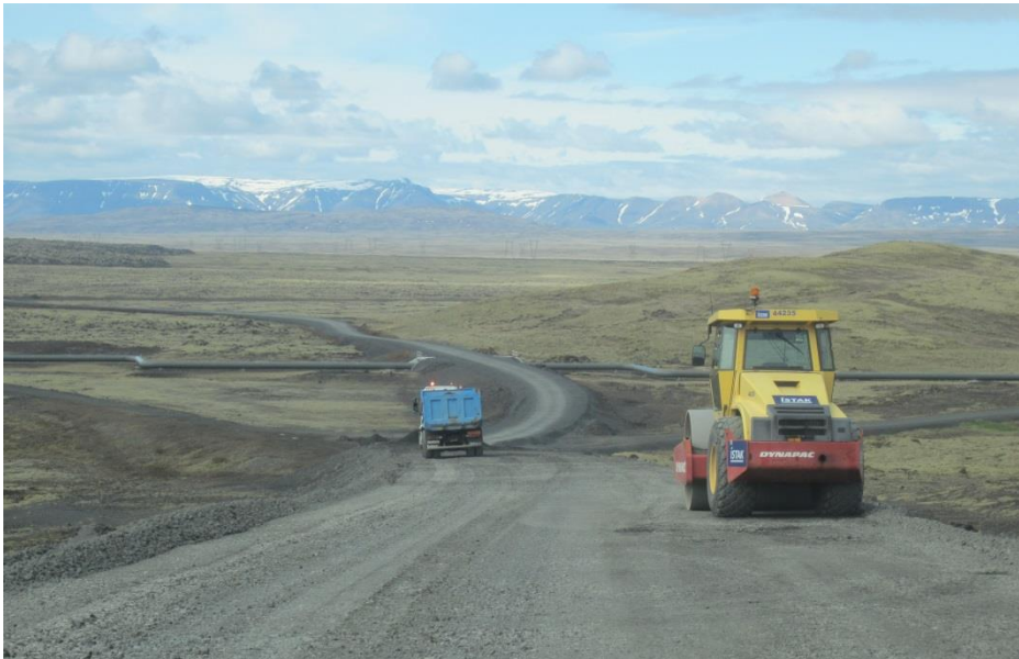
Mynd 27 Unnið við framkvæmdir Breikkunar Hringvegjar á milli Hamragilsvegjar og Hveragerðis
